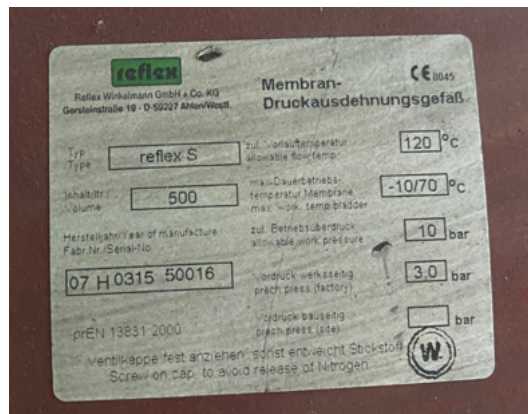
Widok naklejki znamionowej naczynia wzbiornczego Reflex S 500
