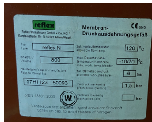
Widok naklejek znamionowych naczyń wzbiornczych Reflex N 800
