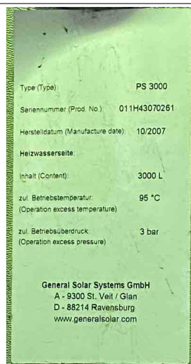
Widok naklejek znamionowych zbiorników buforowych PS 3000
