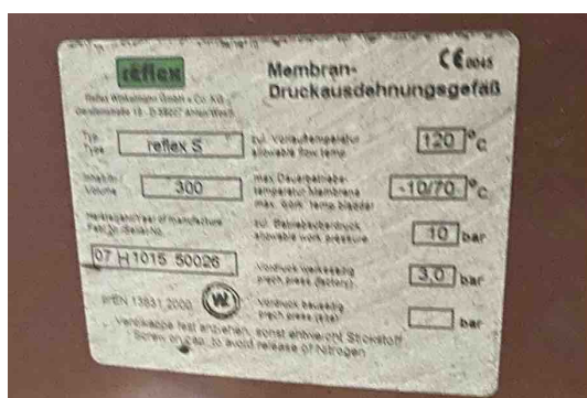
Widok naklejek znamionowych naczyń wzbiorczych Reflex S 300
