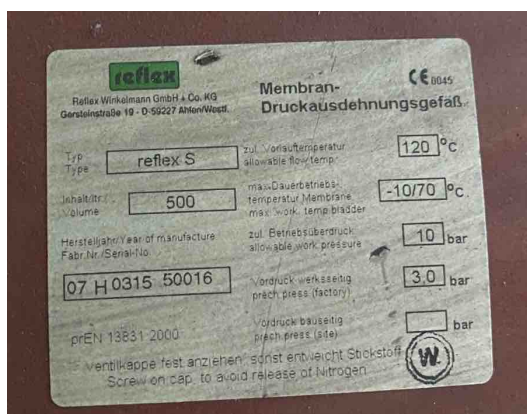
Widok naklejki znamionowej naczynia wzbiorczego Reflex S 500
