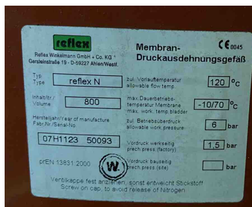
Widok naklejek znamionowych naczyń wzbiorczych Reflex N 800
