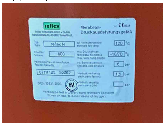
Widok naklejek znamionowych naczyń wzbiorczych Reflex N 800
