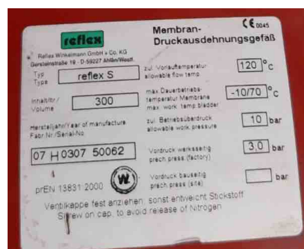
Widok naklejek znamionowych naczyń wzbiorczych Reflex S 300
